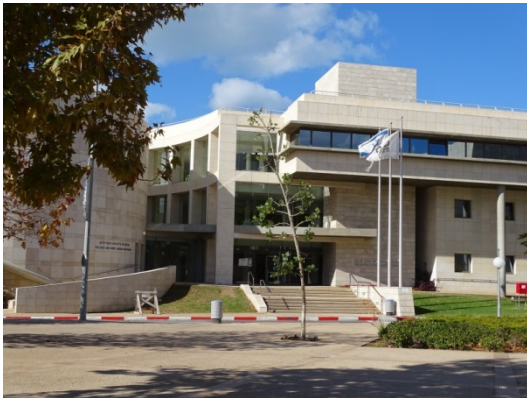
Zentrales Verwaltungsgebäude der TAU
