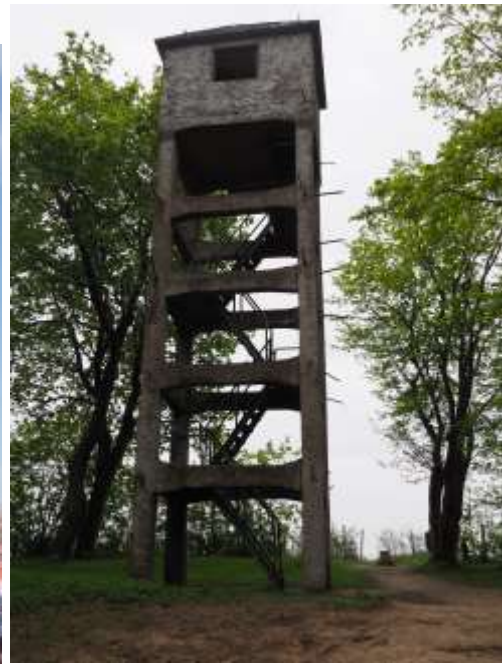
Westerplatte, ehemaliger Wachturm
